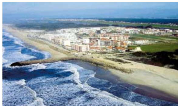
Protection d'une plage et des habitations par enrochements et épis au Portugal
