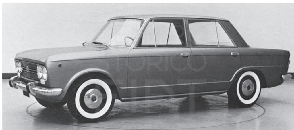
*Per la 130 fu un succedersi di modelli in gesso realizzati al vero. Le dimensioni e la caratterizzazione della vettura rappresentavano un tema impegnativo, sul quale agivano in modo pressante le suggestioni della direzione generale. In foto, il primo modello in gesso elaborato nel 1963.*
