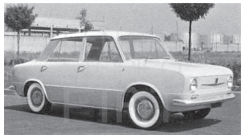
Tipo "122/540": la soluzione ritenuta definitiva nel 1960 (modello in gesso). Come mostrano queste immagini e le seguenti, per la "122" furono eseguiti al Centro stile numerosi modelli al vero. Per evitare il pericolo di cadere nella banale riproduzione di una vettura grande in dimensioni ridotte, furono tentati numerosi partiti stilistici.
