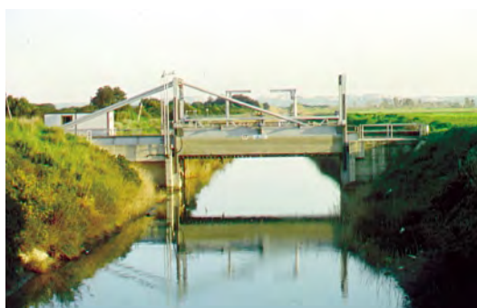
Chiusa su un canale di marea della laguna di Lesina (FG). Foto di L. Tancioni.
