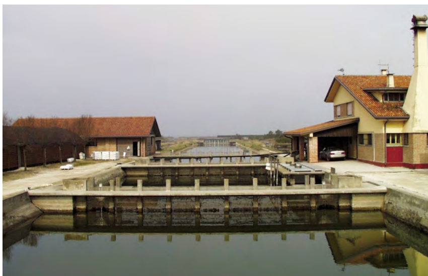
Visione dalla chiavica del colauro, dei lavorieri, della casa di pesca di una valle da pesca. Foto di S. Cataudella.
