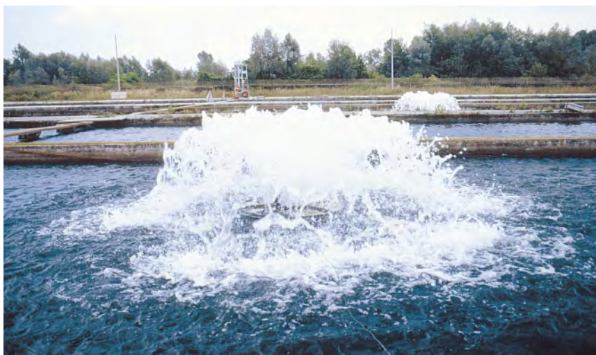
Ossigenatore a fungo. Foto di M. Rampacci.
