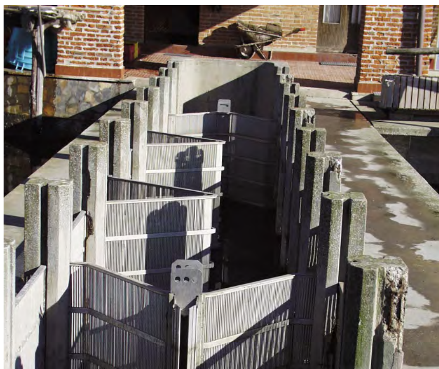
Lavoriero con griglie in posizione di pesca. Foto di S. Cataudella.
