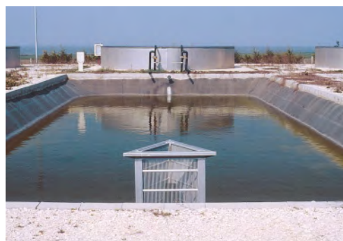
Vasche in cemento. Foto di M. Rampacci.
