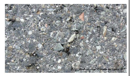
Abbildung 10: Extrem griffiger Asphalt-Belag
