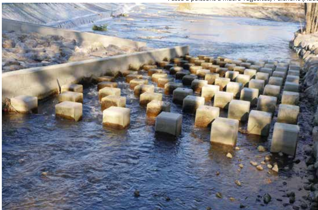
Passes à poissons à macro-rugosités, Puichéric (Aude)
