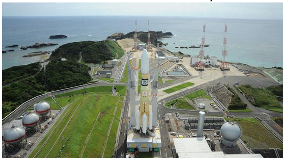
La fusée H-II sur le pas de tir de Tanegashima
