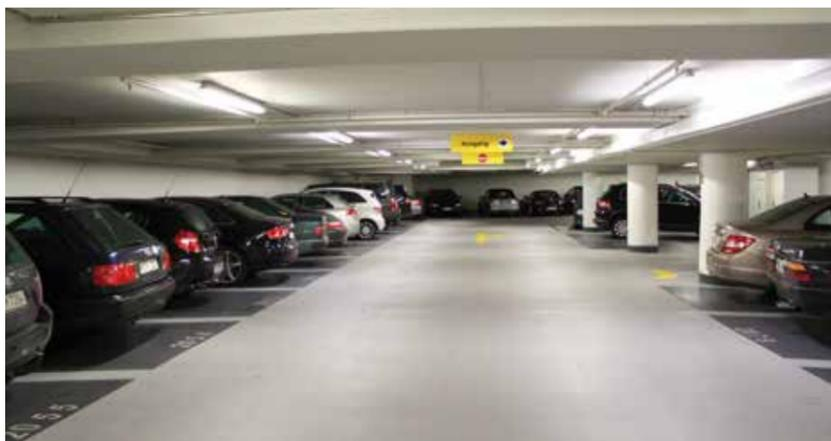
Gleichmäßige Helligkeit durch Deckenleuchten in doppelter Reihe über der Fahrgasse und durch hellen Anstrich an Decken, Wänden und Säulen
