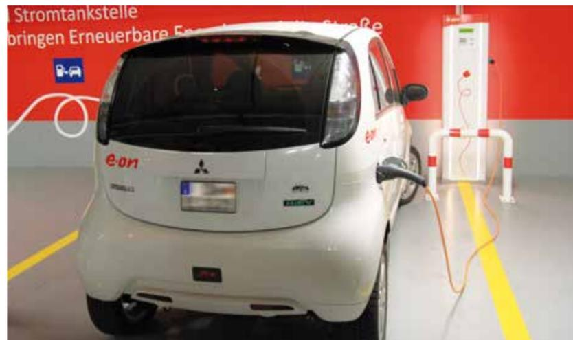
Stromtankstelle mit Führung des Fußgängerverkehrs hinter den Fahrzeugen zur Vermeidung von Stolperfällen
