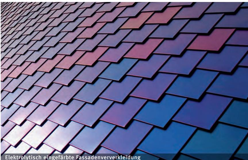
Elektrolytisch eingefärbte Fassadenverkleidung
