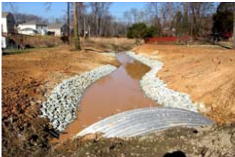
Rip Rap Toe
