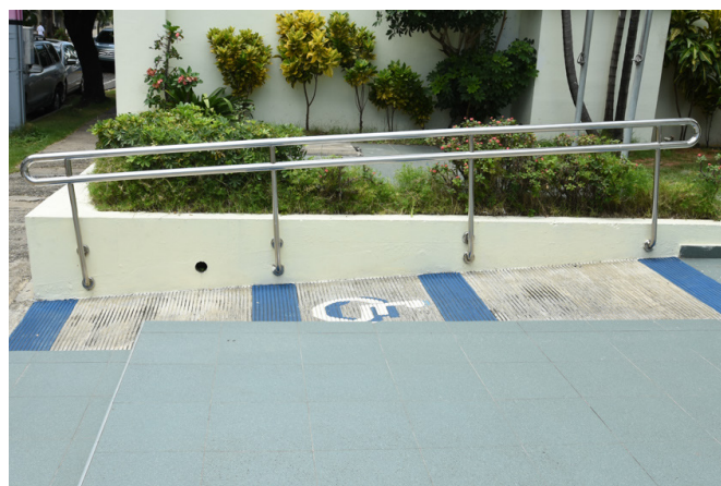
Rampa acceso señalizada
