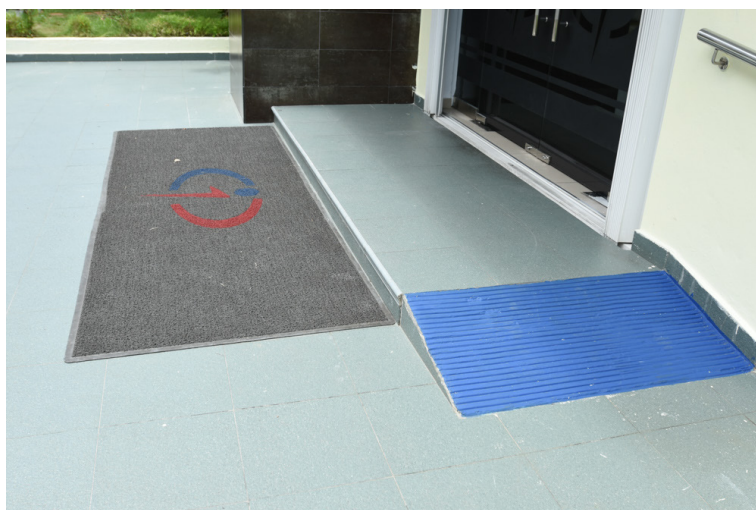
Rampa acceso instalación señalizado
